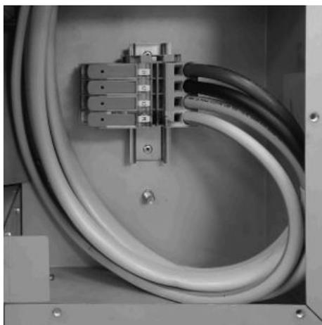
Fig. 24: Bornes en la caja de conexión
